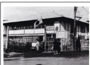
再々建時の病院(20床) 昭和 22 年
